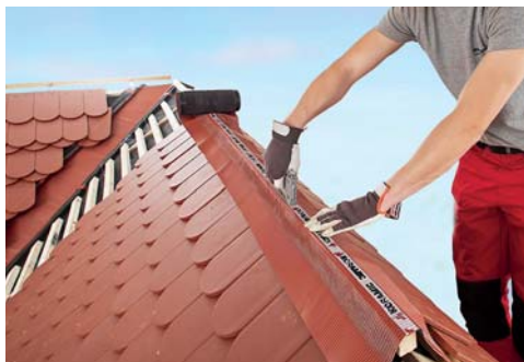
Zdj. 9. | Rozwijanie i mocowanie taśmy do łąty kalenicówek
