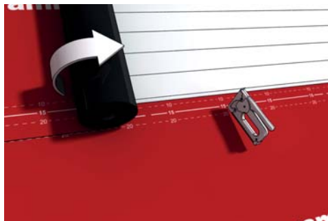
Rys. 82. | Zakład kolejnego pasa membrany
