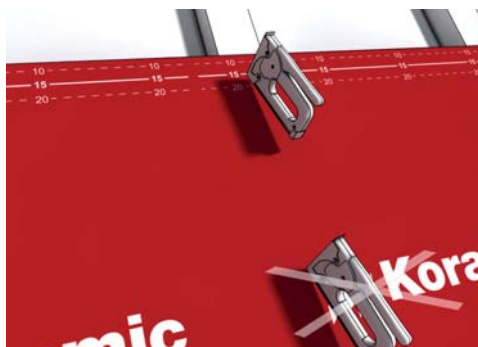
Rys. 83. | Mocowanie membrany do podłoża
