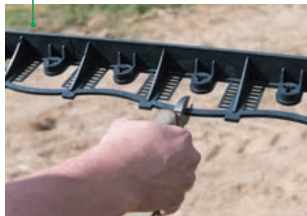
Przecięcie zewnętrznych poprzeczek
