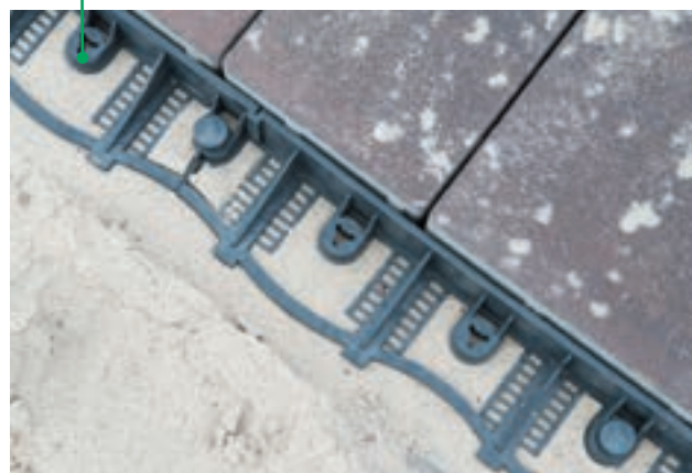
Połączenie dwóch obrzeży wspólnym trzpieniem
