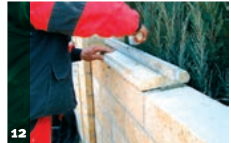
12 Osadzając daszki należy kontrolować wypoziomowanie.
