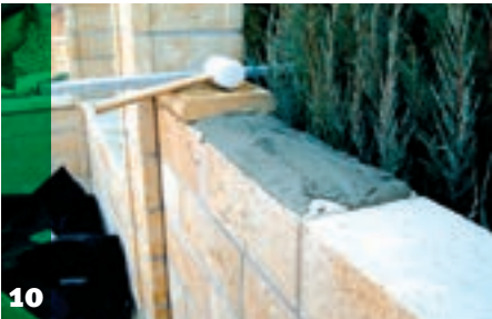
10 Na końcu mocujemy daszki na klej mrozoodporny i wysokoelastyczny.
