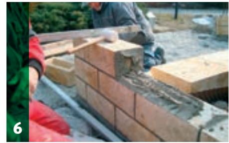
6 Pozostałe warstwy należy układać zgodnie z zaleceniami z ilustracji 2. W ciągu jednego dnia można maksymalnie ułożyć od 3 do 4 warstw, aby nadmierne obciążenie nie powodowało wyciskania nie zaschniętej zaprawy.
