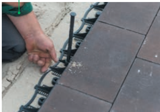
Połączenie dwóch obrzeży wspólnym trzpieniem
