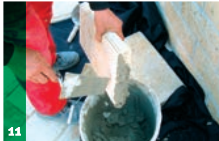
11 Aby spoinowanie było łatwiejsze, zaprawę należy nakładać na powierzchnię stykową daszków.
