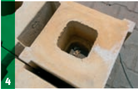
4 Przed osadzeniem kamienia na słupek należy przebić betonową skorupę.
