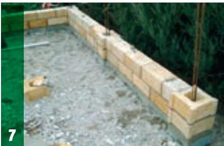
7 Wykonany został drugi rząd muru. Należy często kontrolować poziomowanie poszczególnych kamieni.
