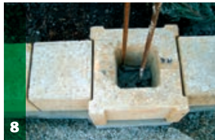
8 Jednocześnie z murem należy stawiać słupki, które buduje się tak samo.
